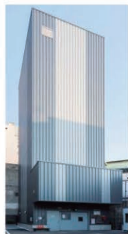
タワー型 立体駐車場 20台 (1泊:2,000円)
